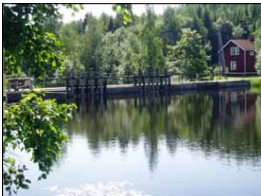
Figur 9. Vattenkraftverk i Rastälven, ovanifrån (tabell 3, hinder 2).
