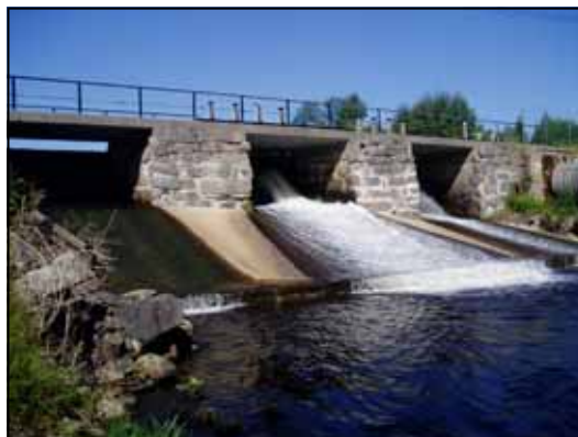
Figur 10. Vattenkraftverk i Rastälven, nerifrån (tabell 3, hinder 2).
